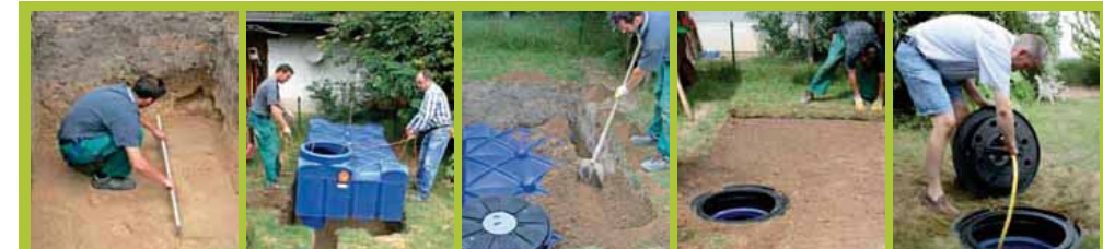
Rappel : le déblai d'excavation ne convient pas au remplissage dans la grande majorité des cas. Se conformer à la notice.
